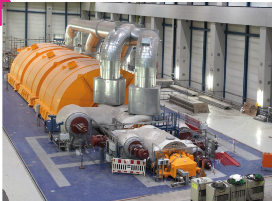
■ OBR. 7: GENERÁTOROVNA UHELNÉ ELEKTRÁRNY. CENA TAKOVÉHO INVESTIČNÍHO CELKU, KTERÝ OBVYKLE ZAHRNÚJE NEJEN STROJNÍ VYBAVENÍ, ALE I STAVEBNÍ ZÁSAHY, SE POHYBUJE V MILIARDÁCH KORUN. DOBA DODÁNÍ JE 2–3 ROKY (GE POWER).
